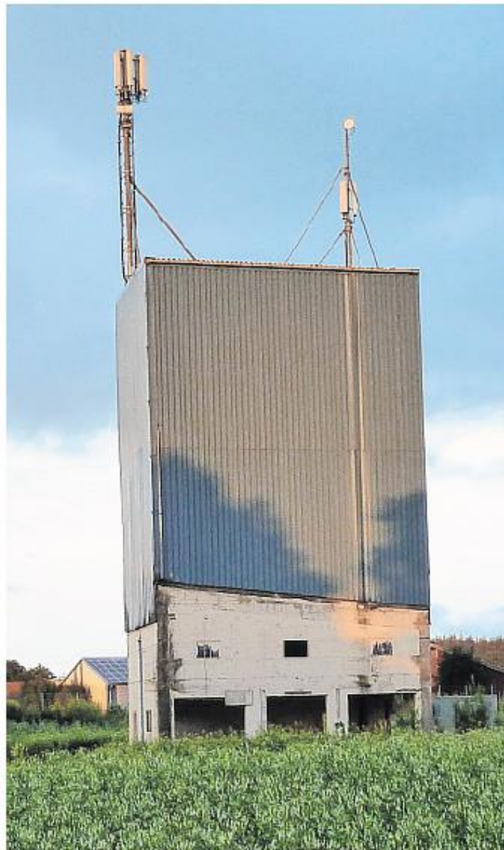
Dieser Turm ist das Zuhause eines Turmfalken-Paares und diverser Schwalben. Der Abriss ist vorgesehen, darf aber erst erfolgen, wenn Ersatz für die Vögel auf dem Gelände geschaffen wurde. KETELS
